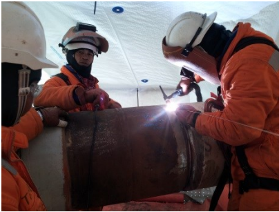
초층 GTAW 용접
